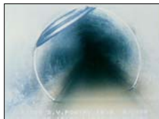
Fig. 3 - Erniatura di una guarnizione "tradizionale" che provoca la possibile infiltrazione di radici con conseguente pericoloso danneggiamento della funzionalità idraulica della condotta.
