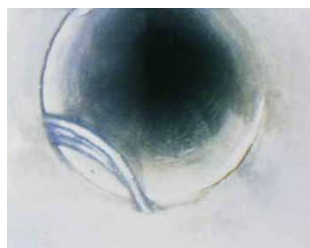
Fig. 5 - Erniatura che provoca la fuoriuscita del liquido trasportato (pericolo di inquinamento dell'ambiente) e anomala sedimentazione dalla fase solida dei liquami con conseguente variazione delle condotte idrauliche.
