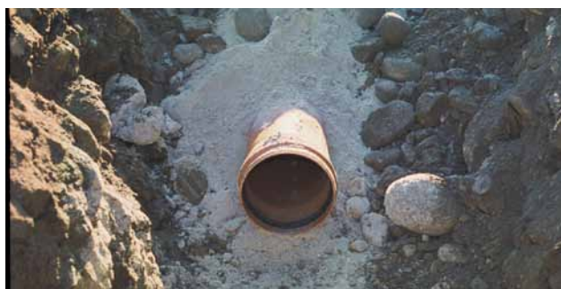
Fig. 17 - Sistemazione in terrapieno (posizione negativa).
